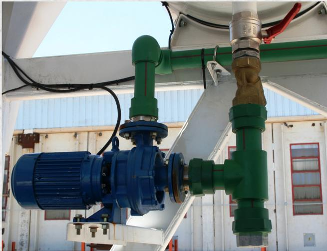
**Sistema de acopio y dosificación de agua** compuesto por tanque de 850 lts. de capacidad con flotante de corte electrónico para conexión a red, caudalímetro Inductivo marca Maddalena de Ø 3", electrobomba de 10 HP, cañerías, mangueras de conducción, llaves esféricas, etc. Regador de descarga en el Mezclador.
