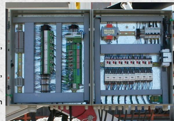
**Sistema de comando INDUCOMAND WET:** posee un Interfaz gráfica intuitiva, que proporciona una rápida interpretación de los datos, con dibujos esquemáticos e indicadores de accionamiento en tornillos sin fin, cintas transportadoras y estado de apertura de compuertas. Carga y almacenamiento de hasta 20 fórmulas diferentes de hormigón y hasta 5 secuencias para ser dosificadas en forma totalmente automática cuando el operador lo ordene.
