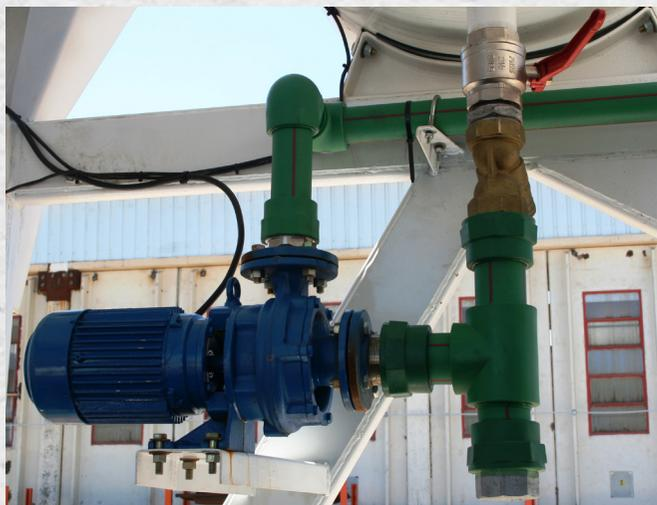
**Sistema de dosificación de agua** compuesto por electrobomba de 3 HP, caudalímetro lanza impulsos marca Maddalena de Ø2", cañerías, mangueras de conducción, llaves esféricas, etc. Regador de descarga dentro del Mezclador Planetario.
