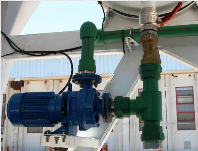
**Sistema de acopio y dosificación de agua** compuesto por tanque de 850 lts. de capacidad con flotante de corte electrónico para conexión a red, caudalímetro lanza impulsos marca Maddalena de Ø 2", electrobomba de 3 HP, cañerías, mangueras de conducción, llaves esféricas, etc. Regador de descarga en el Mezclador.
