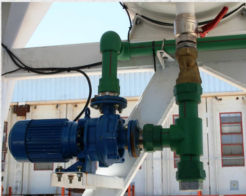
**Sistema de acopio y dosificación de agua** compuesto por tanque de 850 lts. de capacidad con flotante de corte electrónico para conexión a red, caudalímetro lanza impulsos marca Maddalena de Ø 2", electrobomba de 3 HP, cañerías, mangueras de conducción, llaves esféricas, etc. Regador de descarga en el Mezclador.
