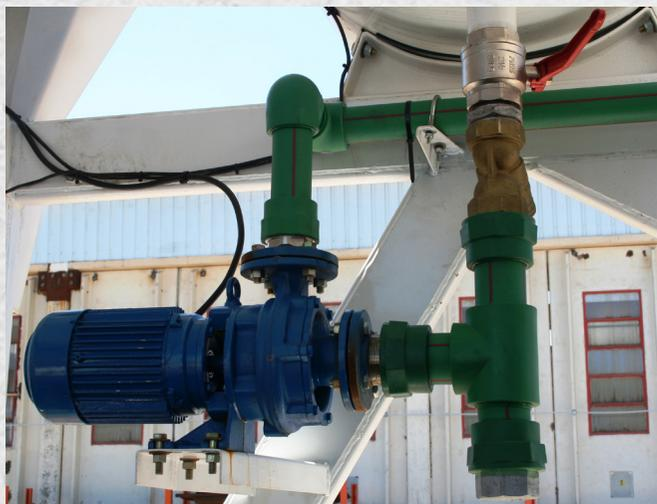
**Sistema de acopio y dosificación de agua** compuesto por tanque de 850 lts. de capacidad con flotante de corte electrónico para conexión a red, caudalímetro lanza impulsos marca Maddalena de Ø 2", electrobomba de 5.5 HP, cañerías, mangueras de conducción, llaves esféricas, etc. Regador de descarga en el Mezclador.
